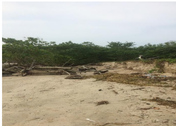
Figure 9: Erosion effect at coordinate 1;41;10.059000, 103;5;50.598500
